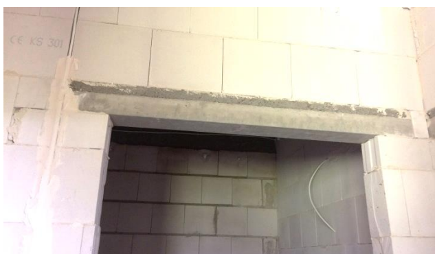
1 nosný překlád na dělicí příčka 115 mm
