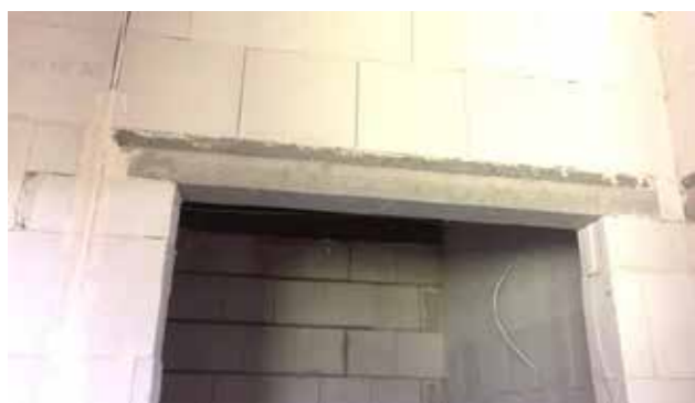
1 nosný překlad na dělicí příčce 115 mm
